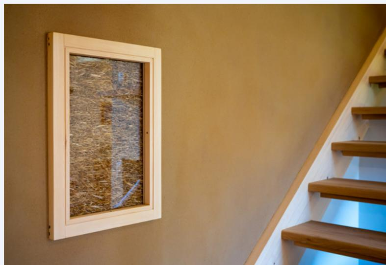
La struttura è costituita da una costruzione in legno riempita con paglia termoisolante e intonacata con argilla.
