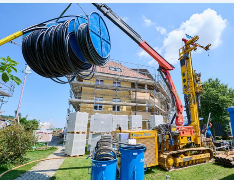
Perforazioni per la pompa di calore (sonda geotermica) che sostituisce il vecchio riscaldamento a gasolio.
