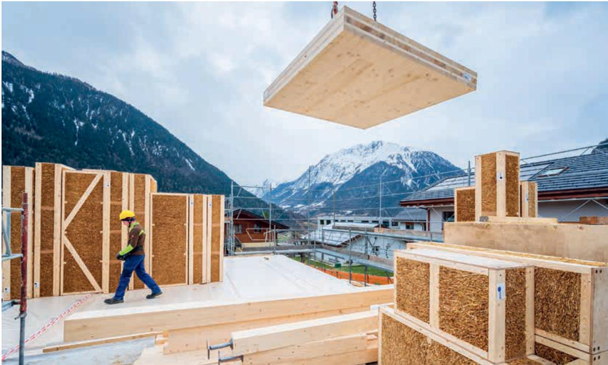
Nouvelle construction d'une maison locative d'après une norme exigeante à Vollèges (VS), dont les murs sont constitués de paille thermiquement isolante.
